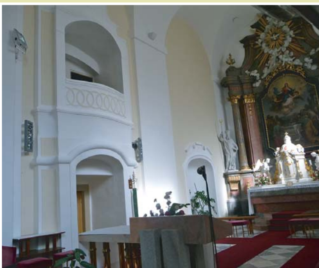
Obnova interiéru v kostele Nanebevzetí Panny Marie – Kyjov
